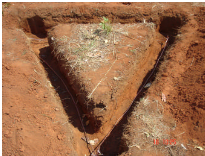
Figura 2 – Malha de Aterramento Tradicional.
